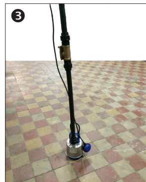
Pumpinredning monterad och klar.
