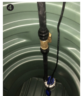
Pumpinredning monterad i kombibrunnen som nu blivit en pumpbrunn inklusive pump.
