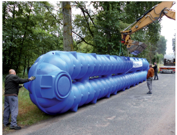
Installation av NEO-avloppstank 25 000 liter
