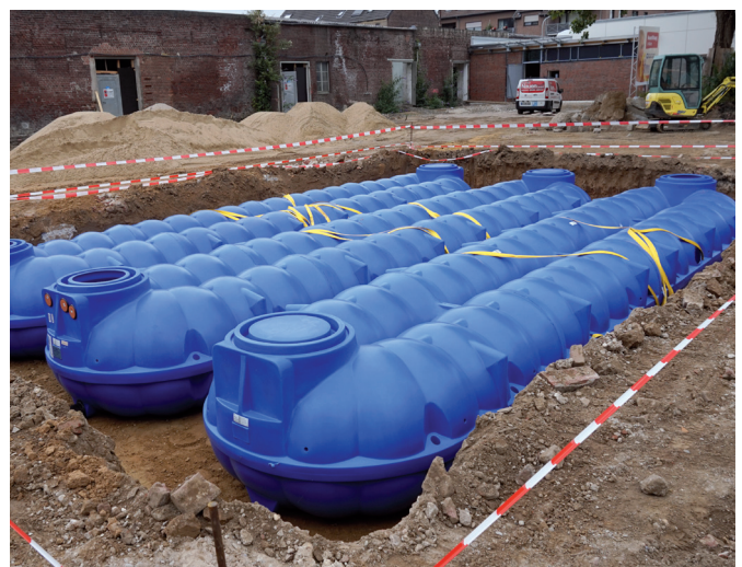
Installation av NEO-regnvattentankar 3 x 20 000 liter
