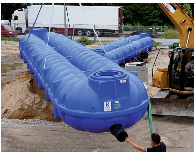
Installation av NEO-avloppstankar 2 x 25 000 liter
