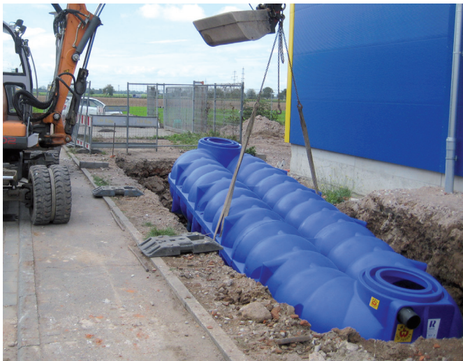
Installation av NEO-infiltrationstank 15 000 liter
