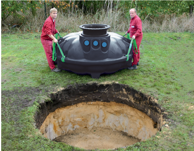
Installation av NEO-regnvattentank 3 000 liter
