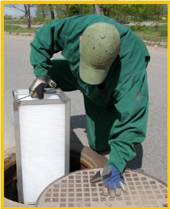
Figure 22. Koalescensmoduler/filter lyfts från oljeavskiljaren
