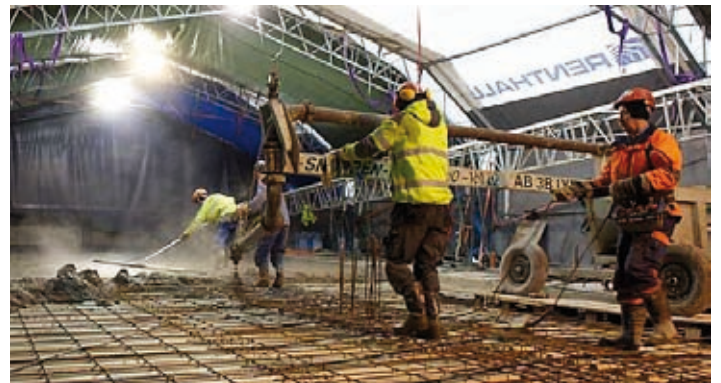
Vid pågjutning av större ytor planeras etappavstängning.
